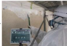
③手工具ケレン工法
