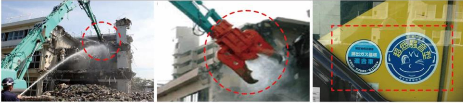
解体重機 圧砕工法 (低騒音・低振動)
