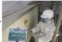
②剥離剤塗布
