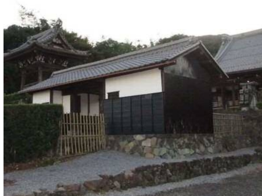
津屋城跡山門の壁面修繕
