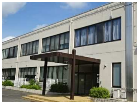
平田中南舎外壁改修工事完了
