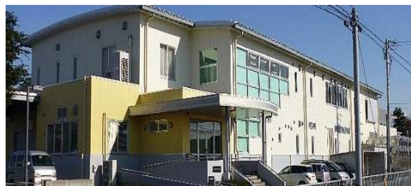
海津市学校給食センター(平田町今尾地内)
