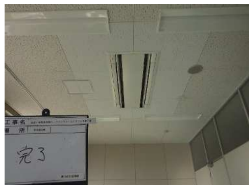
エアコン改修工事 完了後 (旧高須小学校体育館ミーティングルーム)
