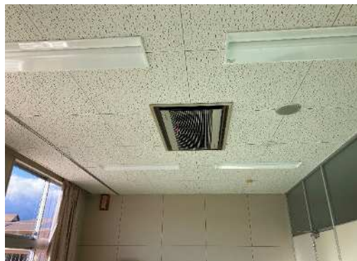
エアコン改修工事 着手前 (旧高須小学校体育館ミーティングルーム)
