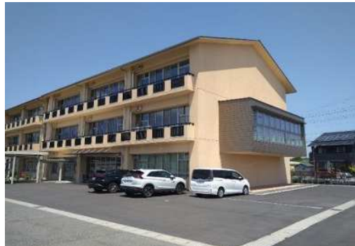
海津小学校増築棟の完成
