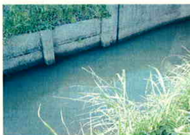
（護岸が整備された水路・河川）
