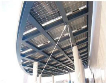
図表 13 建物一体型太陽光発電システム例
