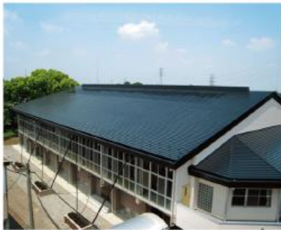
図表 13 建物一体型太陽光発電システム例
