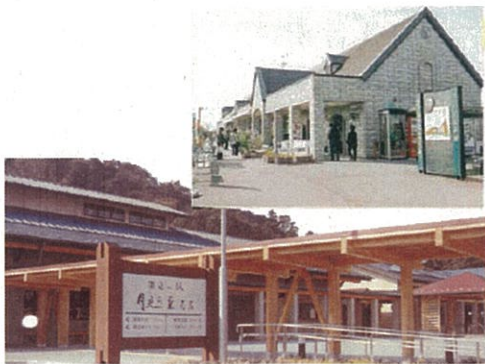
再振興を計画している市内道の駅 (2箇所)
