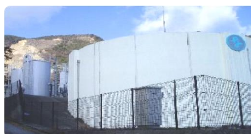
南濃太田浄水場・配水池
