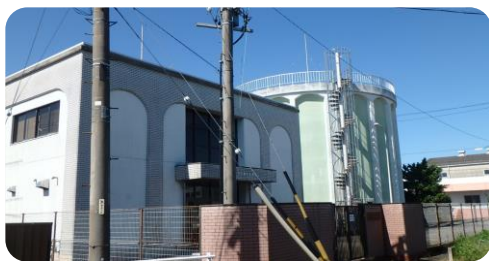
平田第1水源地
