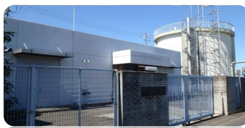
平田第2水源地
