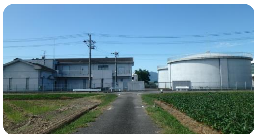
海津北部浄水場
