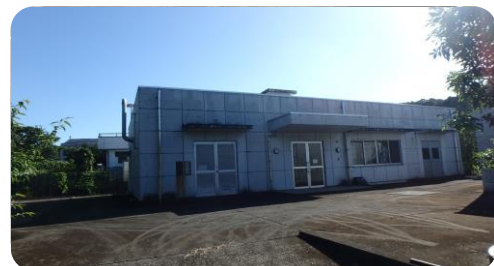
南濃藤沢浄水場
