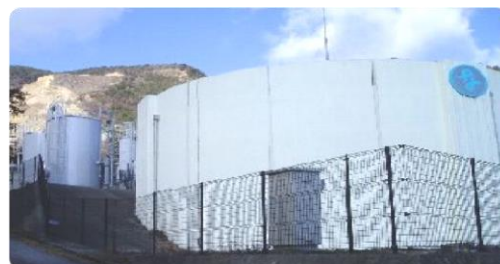
南濃太田浄水場・配水池
