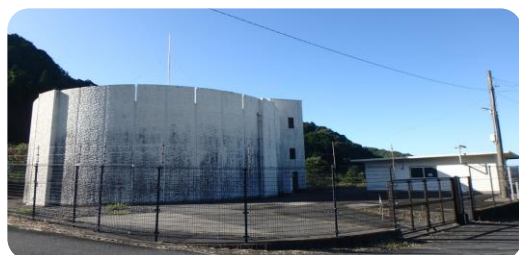
南濃奥条配水池
