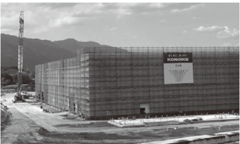
建設中の(株)ジーテクト「中部工場」
