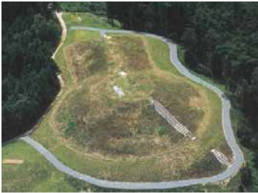
史跡雨の宮古墳群 2号墳(石川県) 墳丘流出部を盛土によって修復
