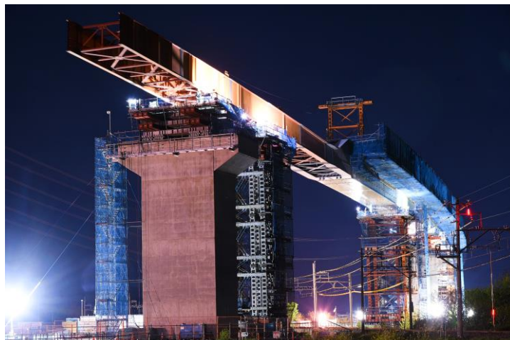
東海環状自動車道工事状況 令和 4(2022)年 4月 岐阜国道事務所提供
