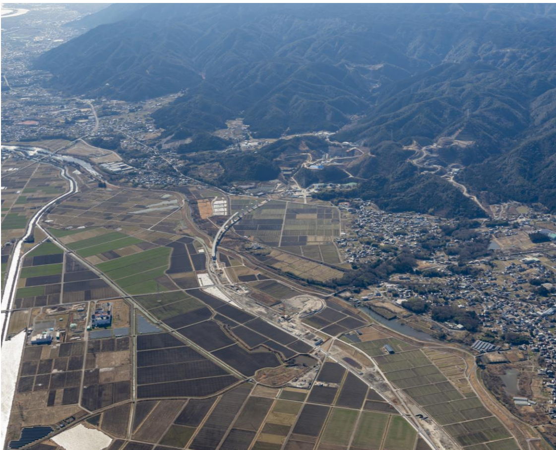
整備が進む(仮称)海津スマートインターチェンジ周辺 令和5(2023)2月 岐阜国道事務所提供
