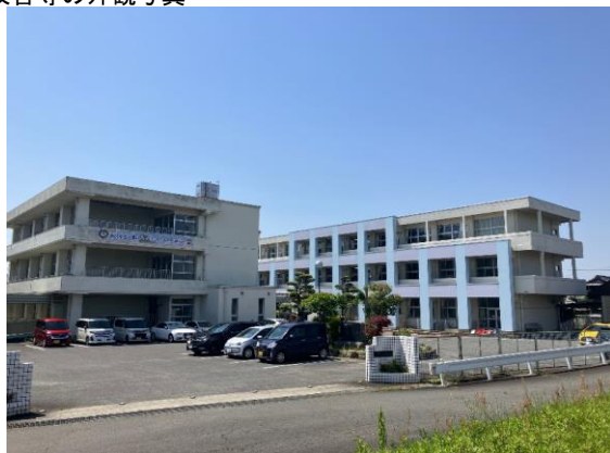
校舎等の外観写真
