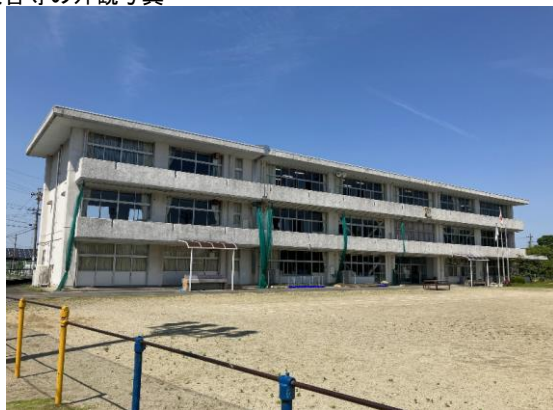
校舎等の外観写真
